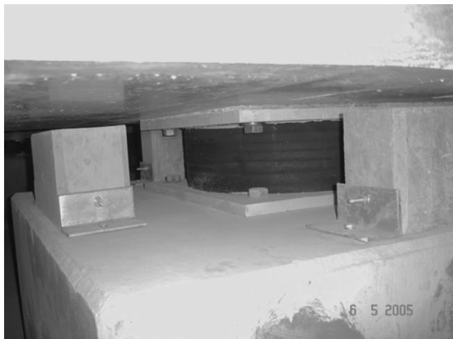
Vista dum Aparelho de Apoio HDRB Instalado
